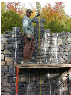
Andy Goldsworthy sur le chantier du Refuge d'Art – Col de l'Esuichière, 2010
