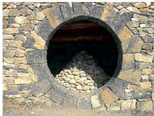
Refuge d'Art Bains thermaux, Digne-les-Bains, 2002
